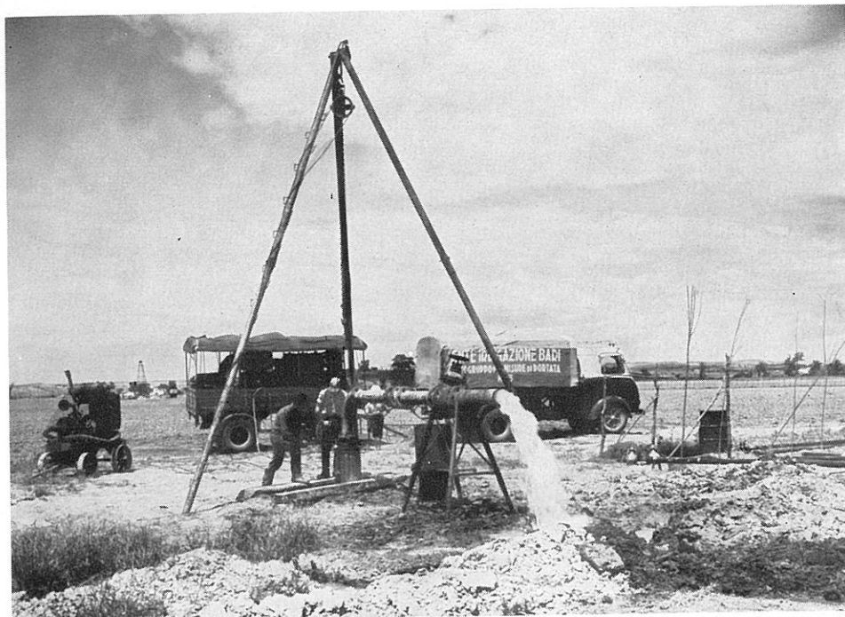
Fig. 3 — Attrezzatura autotrasportata dell'Ente Irrigazione per misura di portata in pozzi trivellati.
