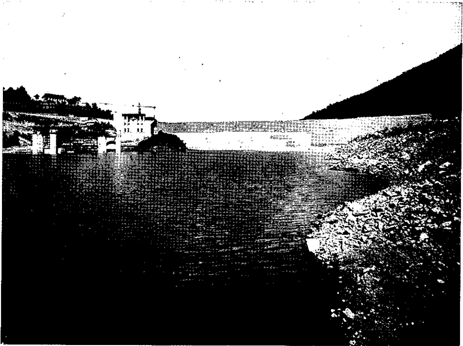
Diga in terra sul torrente Camastra, progettata e costruita dall'Ente Irrigazione, che realizza un invaso di 40 milioni di metri cubi di acqua, consentendo la possibilità di regolare un volume annuo di circa 130 milioni di metri cubi. Oltre l'utilizzazione irrigua, l'opera consente, attraverso una traversa di derivazione, dal fiume Basento ed una condotta di circa 16 km con impianto di depurazione, l'approvvigionamento idrico della zona industriale della valle del Basento.
